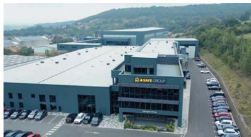
Hoofdkantoor in Engeland
